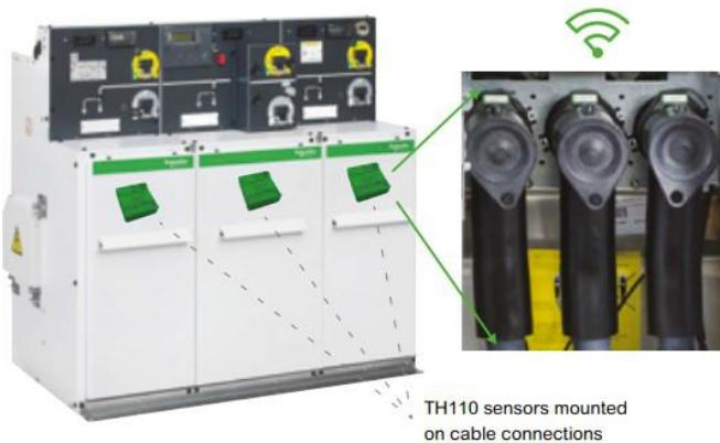
Abb.: Beispiel einer RMU. Detail GIS-Kabelendverschlüsse und externe Temperatursensoren
