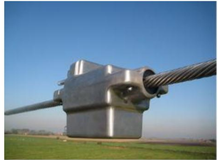
Montage von Smart Grid Sensoren an einer 150 kV Freileitung (Belgien)
