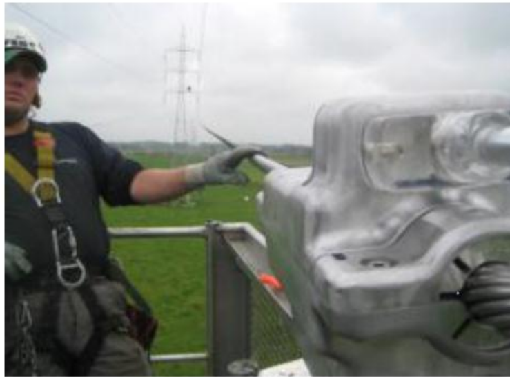
Montage von Smart Grid Sensoren an einer 150 kV Freileitung (Belgien)
