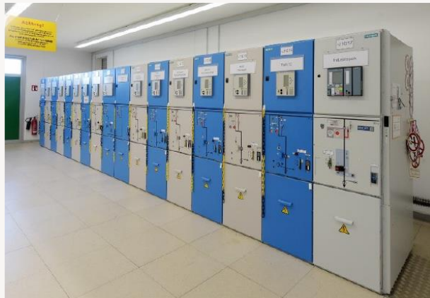
Installation der Pilotanlage (24 kV GIS)
