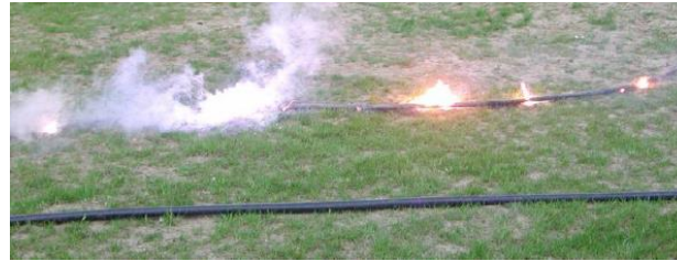
Freileitung auf Erde, 110 kV Erdschlussversuch (P0564 Österreich)
