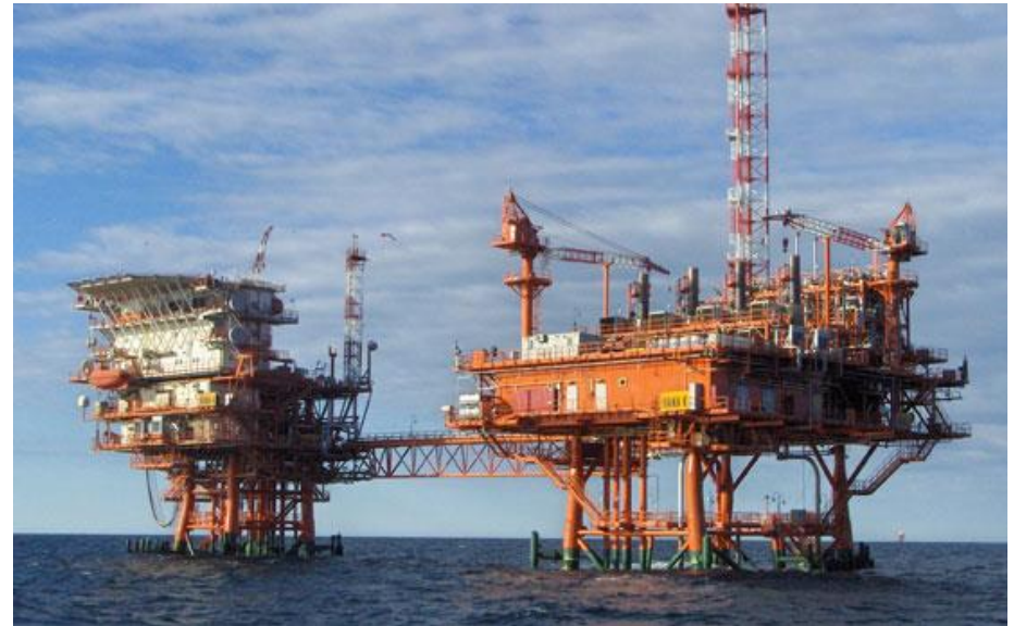
Ivana A und K off-shore Gas Platform (4 x 406 kVA) (P01279 Kroatien)
