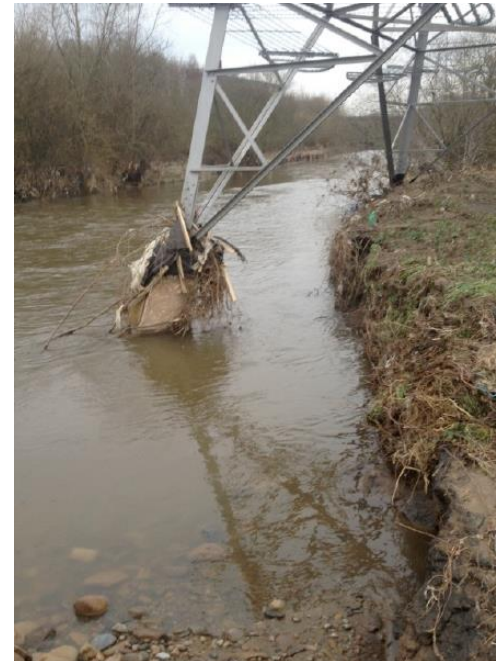
Unterspülter 132kV Mastfuß (P0405 UK)
