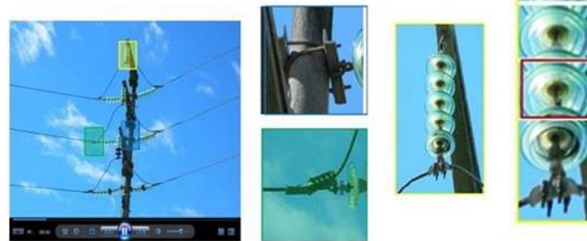
Leitungsbefflegung, Sensoren im Helikopter (P0290 Brasilien)
