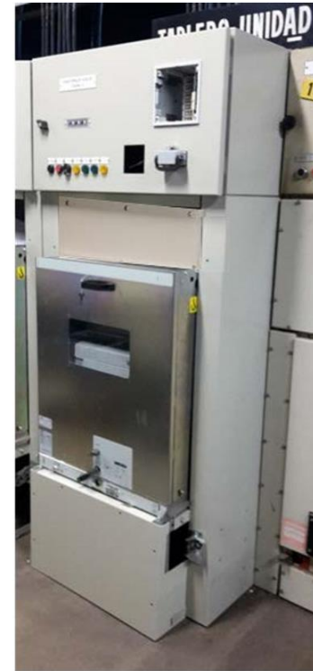
Bild 8 von Paper 796: „Retrofill“ - Motorisierung für ein Upgrade von einem ölarmen Leistungsschalter (Gestell)
