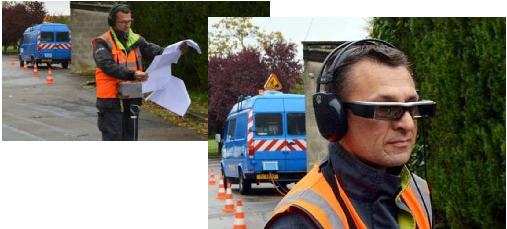
Bild 8 von Paper 413: Techniker ausgerüstet mit Brillen für Erweiterte Realität (schnelleres Lokalisierung von Erdkabeln über GPS, weniger Vorbereitungszeit, mehr Sicherheit durch freies Sichtfeld), Frankreich
