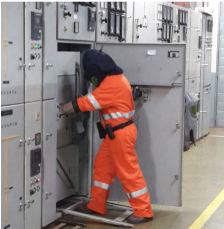
Bilder 1 und 3 von Paper 796: Einfahren eines MV Leistungsschalters bei offener Tür. Retrofit: „Roll-In Replacement“ oder „Retrofill“, Erhöhung Arbeitssicherheit durch Motorisierung, Italien
