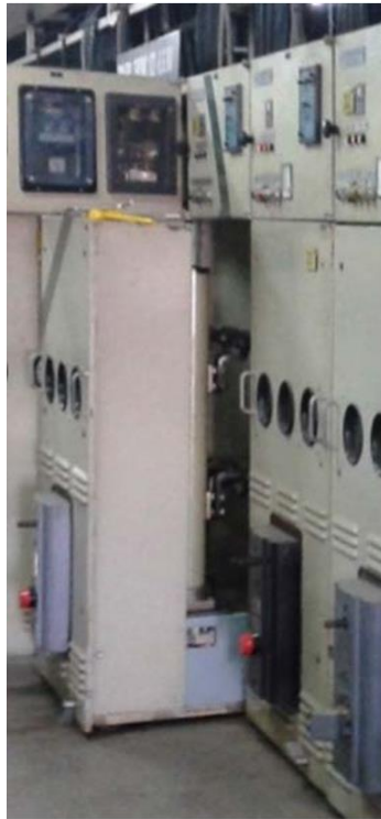
Bild 8 von Paper 796: „Retrofill“ - Motorisierung für ein Upgrade von einem ölarmen Leistungsschalter (Gestell)
