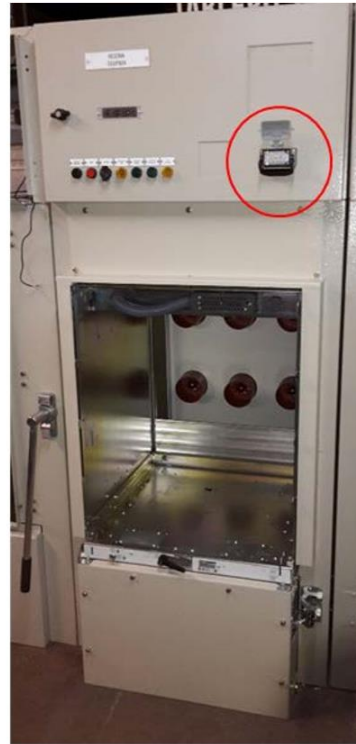
Bild 8 von Paper 796: „Retrofill“ - Motorisierung für ein Upgrade von einem ölarmen Leistungsschalter (Gestell)
